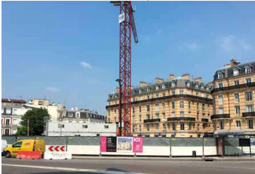
Maï 2018 INSTALLATION DE LA GRUE
