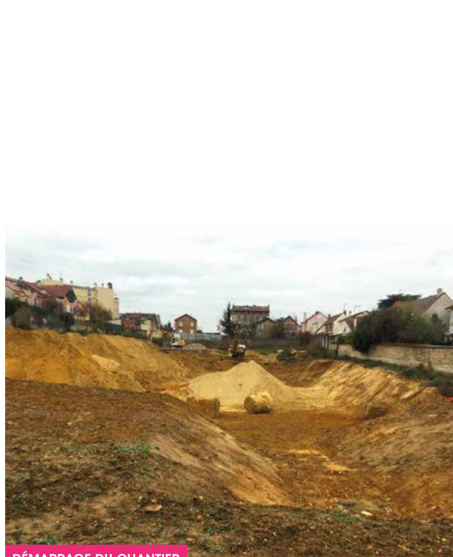
DÉMARRAGE DU CHANTIER
