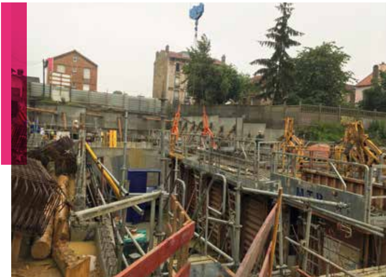
FIN DES FONDATIONS
