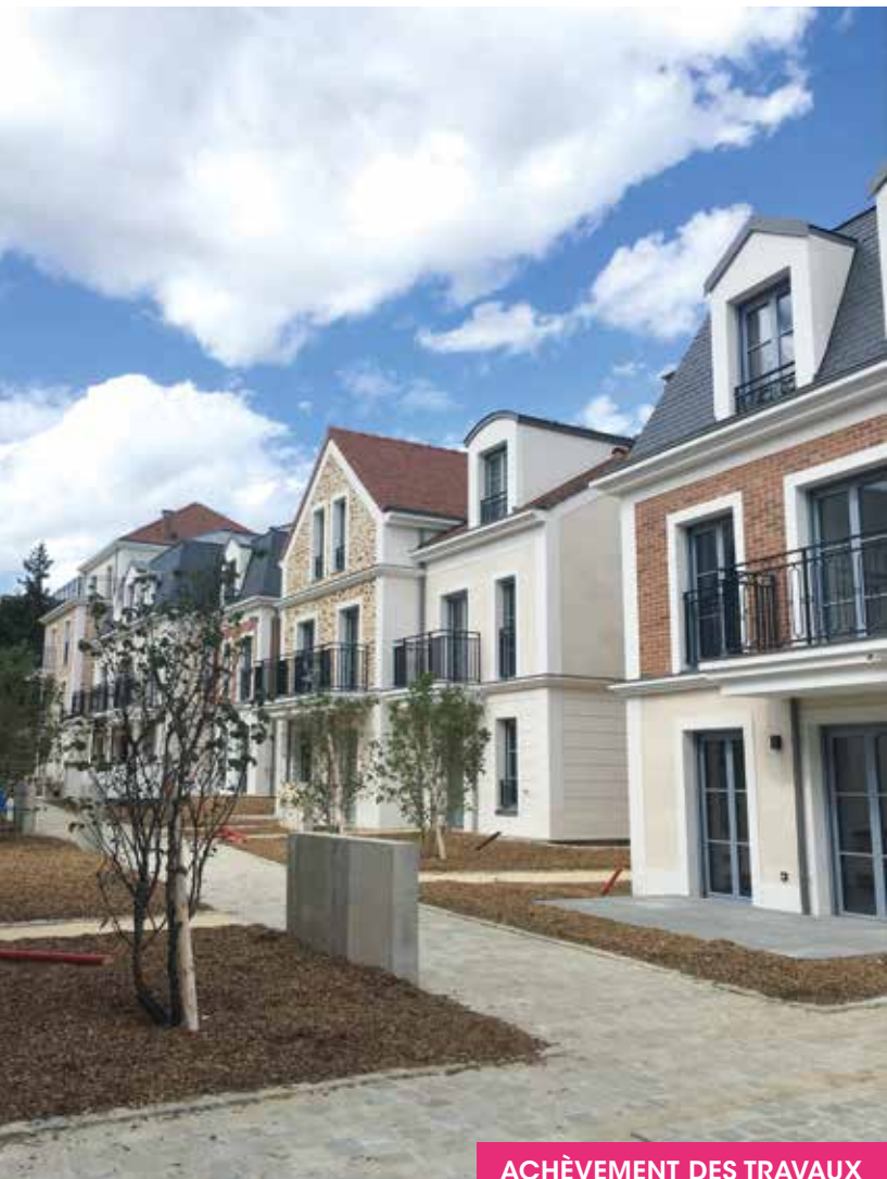
ACHÈVEMENT DES TRAVAUX
