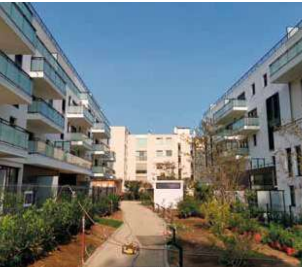
ACHÈVEMENT DES TRAVAUX DU BÂTIMENT A & B
