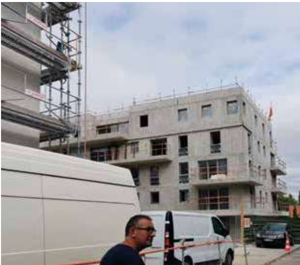
MISE HORS D'EAU ET HORS D'AIR DU BÂTIMENT B
