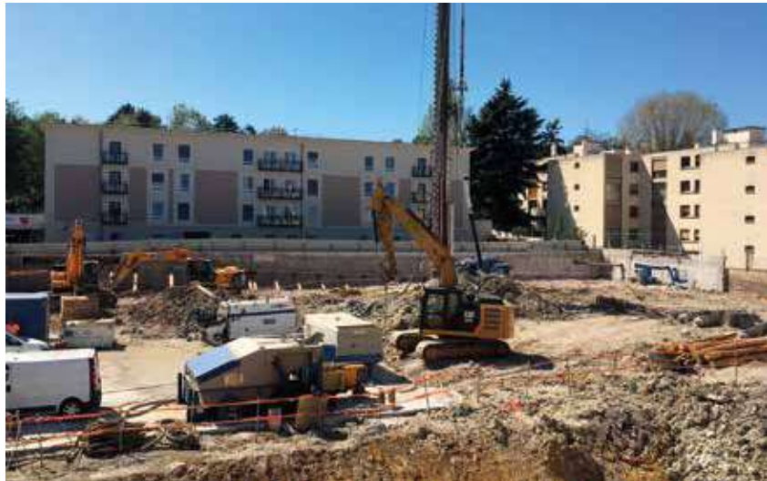
DÉBUT DES TRAVAUX DE CONSTRUCTION
