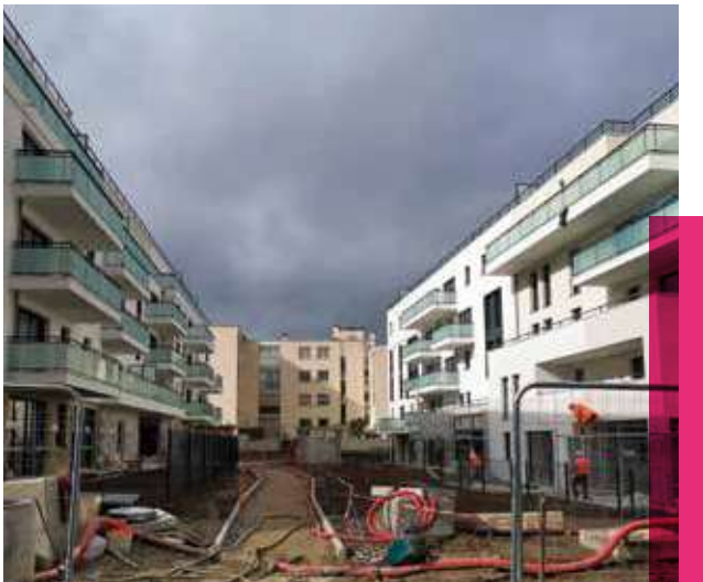
MISE HORS D'EAU ET HORS D'AIR DU BÂTIMENT A
