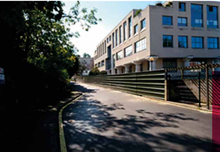
OUVERTURE DU CHANTIER
