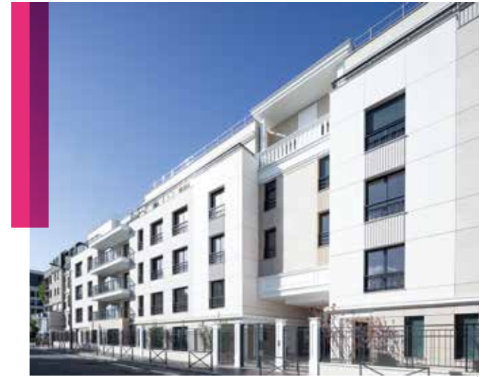
ACHÈVEMENT DES TRAVAUX
