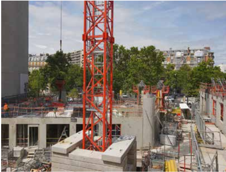
Juillet 2019 FIN PLANCHER BAS RDC
