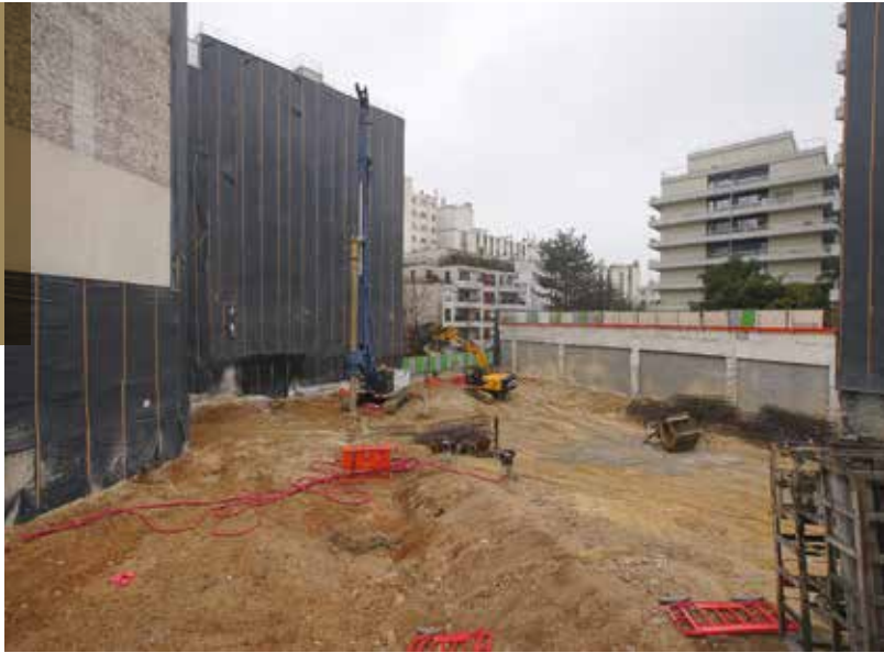
FIN DÉMOLITION ET DÉBUT CONSTRUCTION
