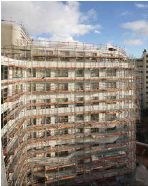
Novembre 2020 MISE HORS D'AIR
