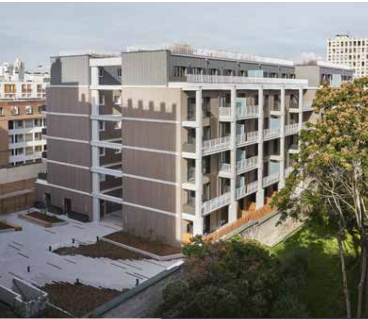
ACHÈVEMENT DES TRAVAUX Octobre 2021
