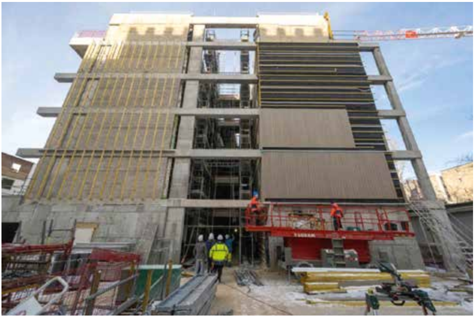
BARDAGE FAÇADES Février 2021
