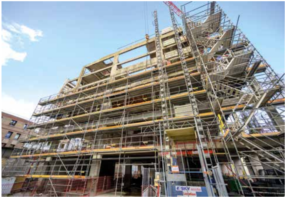
TRAVAUX DE FAÇADES Juin 2020
