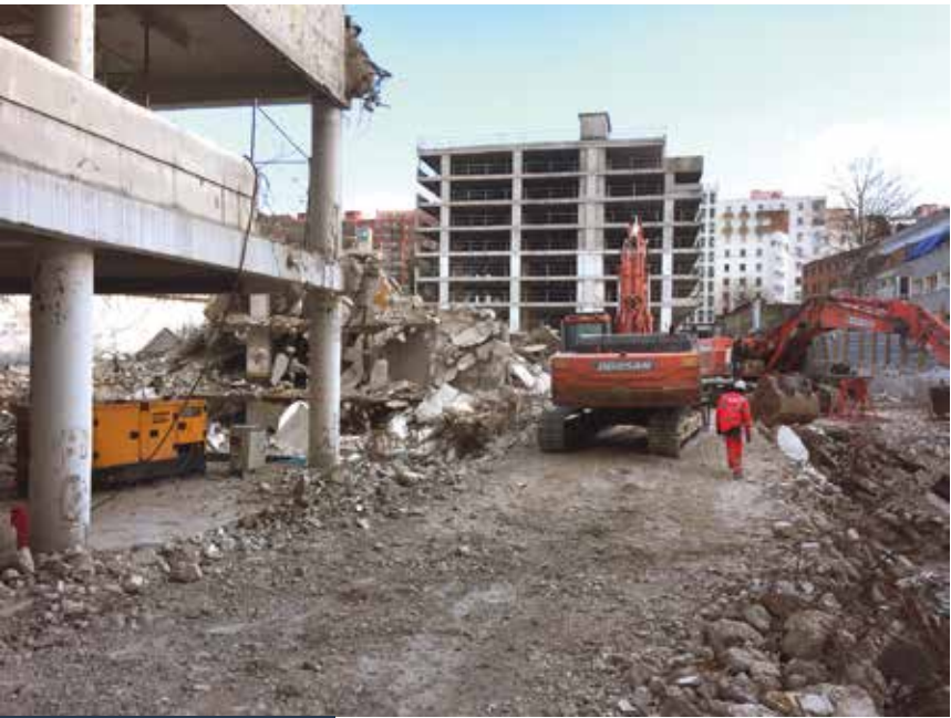
FIN DÉMOLITION Mai 2019
