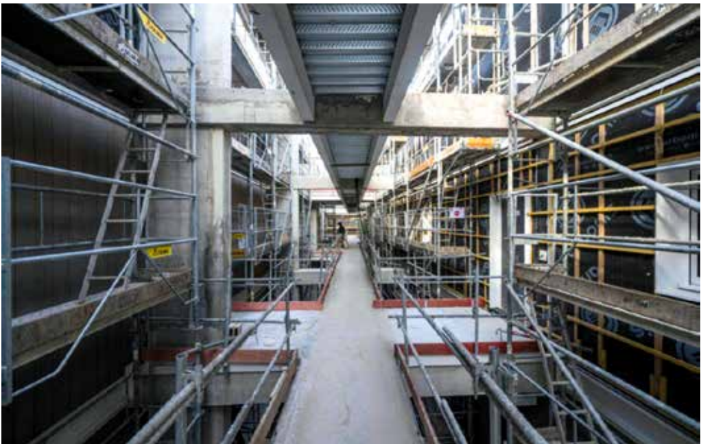
Janvier 2021 COULAGE DES COURSIVES
