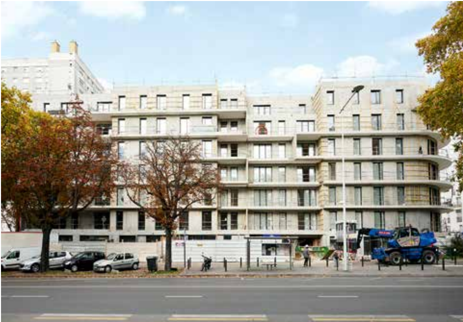
MISE HORS D'EAU/HORS D'AIR JUILLET À NOVEMBRE 2020
