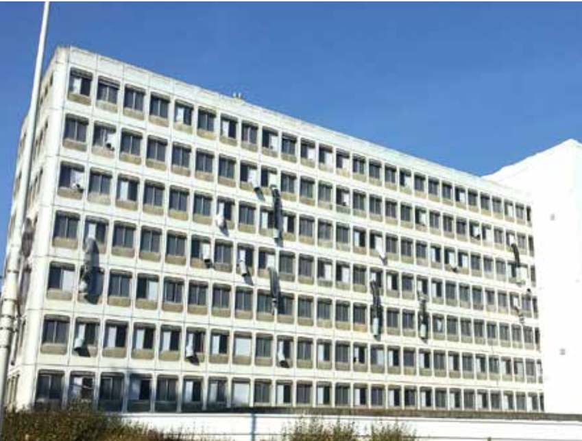
DÉMOLITION DES BÂTIMENTS EXISTANTS AVRIL 2018
