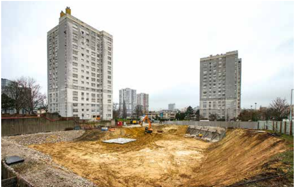
DÉMARRAGE DES TRAVAUX DE CONSTRUCTION
