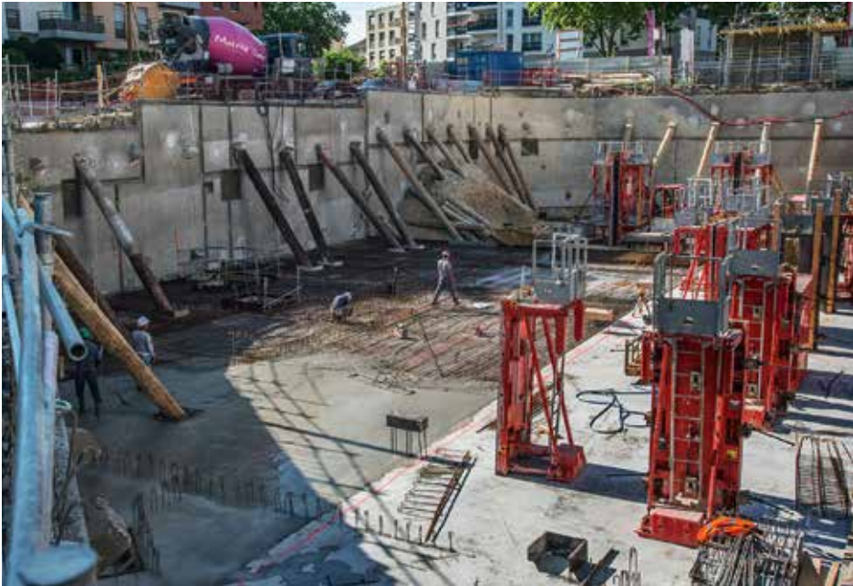
FIN DES FONDATIONS JUIN 2019
