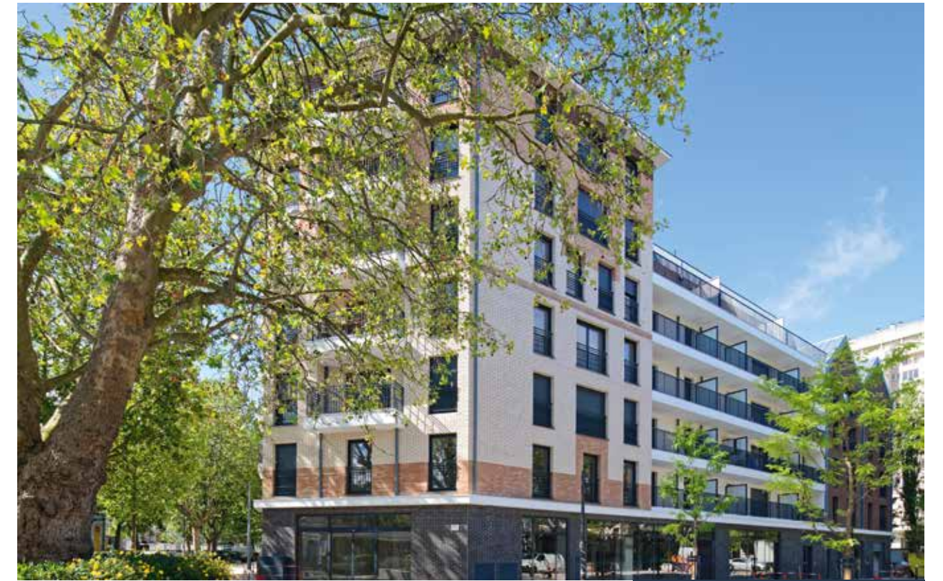
ACHÈVEMENT DES TRAVAUX
