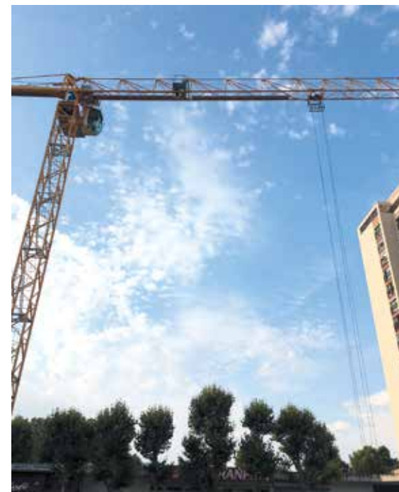
MONTAGE DE LA GRUE
