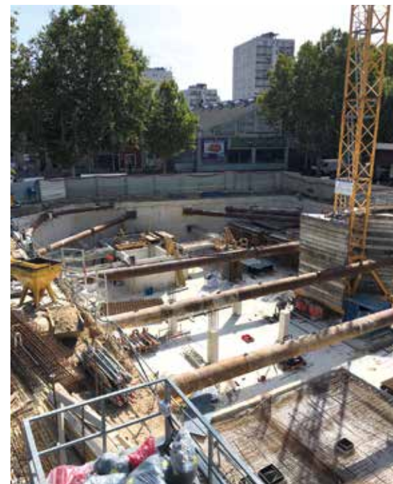
ACHÈVEMENT DES FONDATIONS
