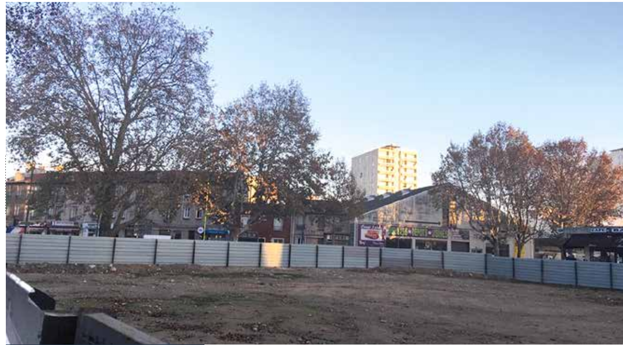
DÉMARRAGE DES TRAVAUX
