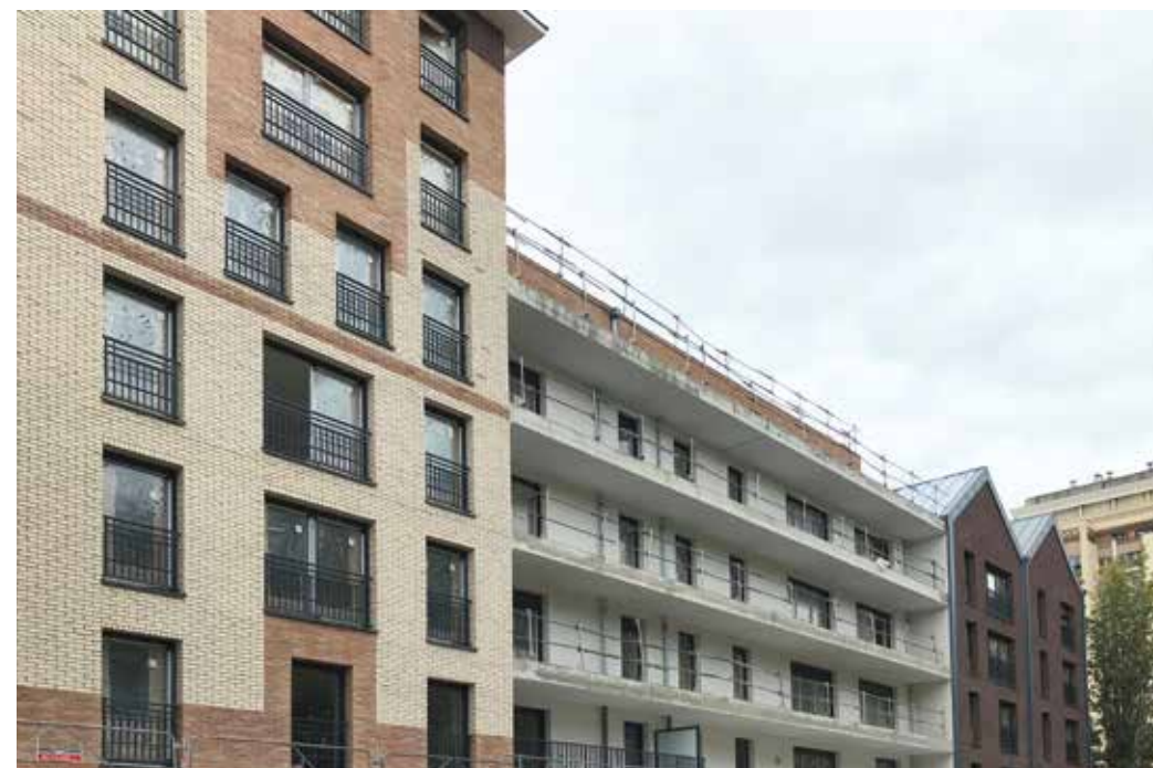
ACHÈVEMENT DES FAÇADES
