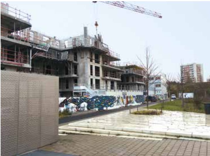
TRAVAUX DE GROS ŒUVRE
