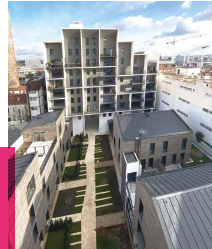
ACHÈVEMENT DES TRAVAUX
