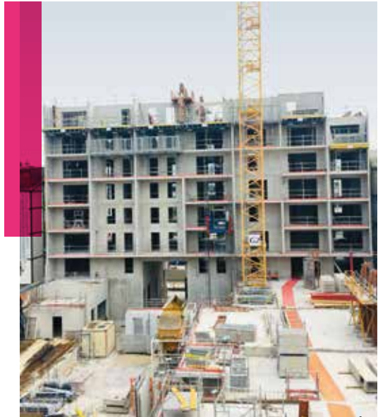
GROS ŒUVRE BÂT. C
