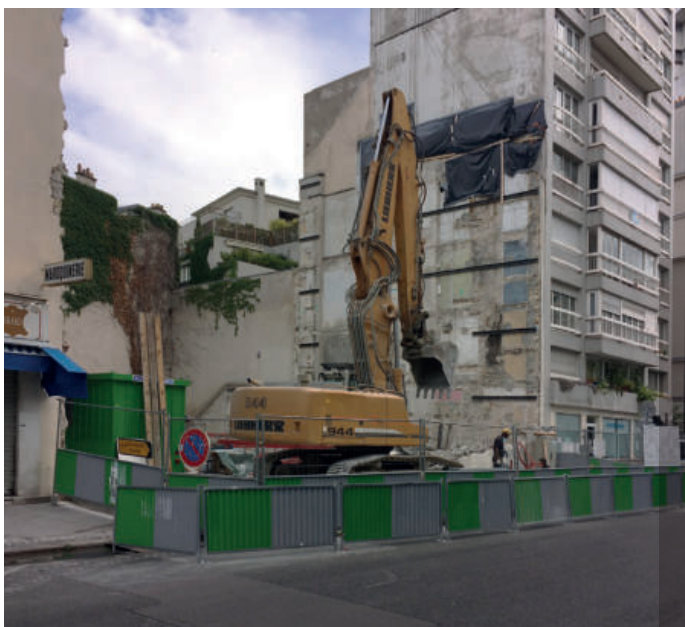
FIN DÉMOLITION SUPERSTRUCTURE
