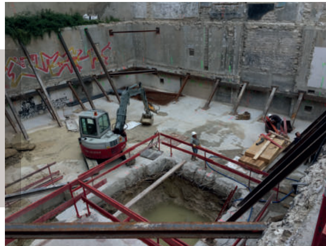
FIN DÉMOLITION INFRASTRUCTURE
