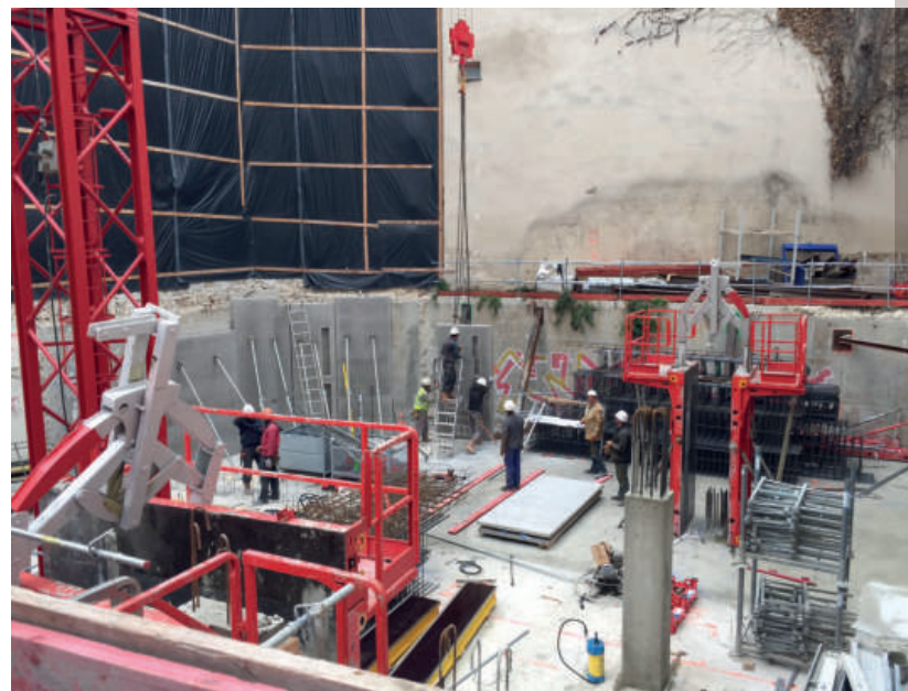
INSTALLATION DE LA GRUE
