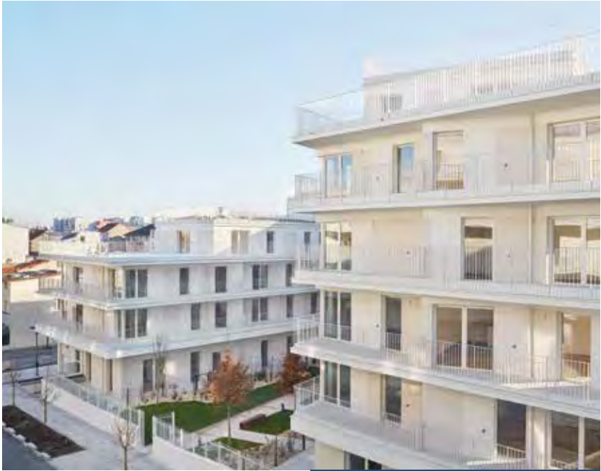
ACHÈVEMENT DES TRAVAUX
