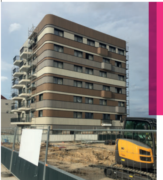
FAÇADES EN COURS (KOPO)
