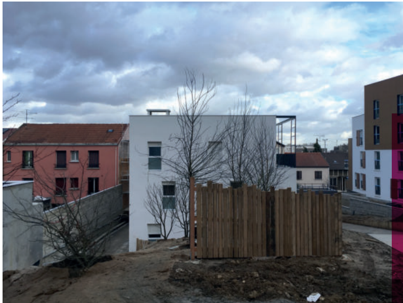
ESPACES EXTÉRIEURS EN COURS
